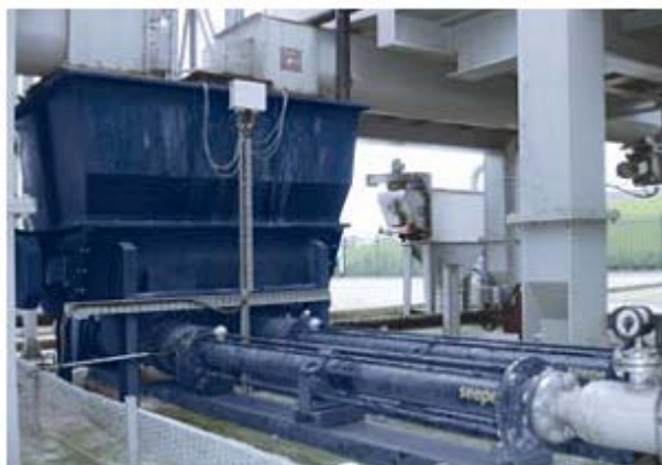
Pompe gama BTEI 17-48 cu rezervor tampon de 6 t cu parte inferioară activă
