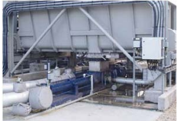
Pompe gama BTHE 130-24R Produs de transport: Turtă de nămol importat cu un conținut ssu de 25-30% Capacitate de transport: 20 m 3 /oră (88 GPM) Presiune: 10 bar (145 PSI) Temperatură: 20-30°C (68-86°F)
