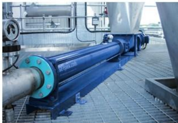
Pompa din seria BT 35-24R Produs vehiculat: Borhot cu un continut solid de 25 % Debit: 6 m 3 /h (26 GPM) • Presiune: 12 bar (174 PSI) Temperatura: 60 °C (140 °F)
