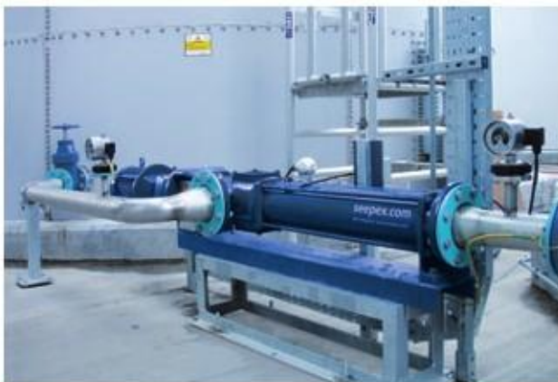
Pompa din seria BN 70-6L Produs vehiculat: Reziduuri de fermentatie Debit: 50 m 3 /h (220 GPM) • Presiune: 3 bar (43 PSI) Temperatura: 10 –20 °C (50–68 °F)
