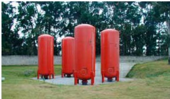
Instalarea unei camere de aer mari pentru protectia sistemului de conducte.
