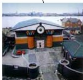
Marea Britanie: Statie de pompare a apelor uzate si pluviale
